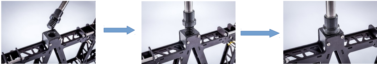
Установка верхнего луча ограждения на раме «Звезда»
